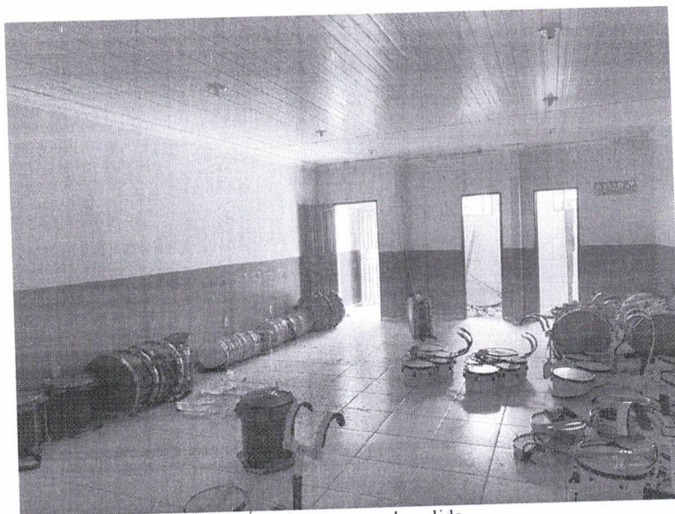
Área interna a ser demolida
