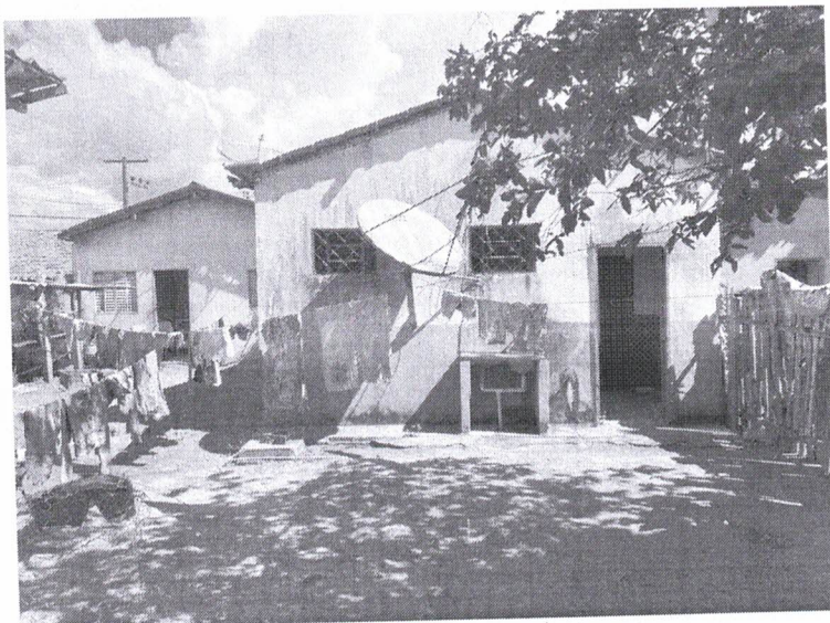
Área a ser demolida limite posterior terreno
