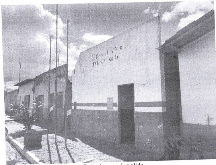
Fachada a ser demolida
