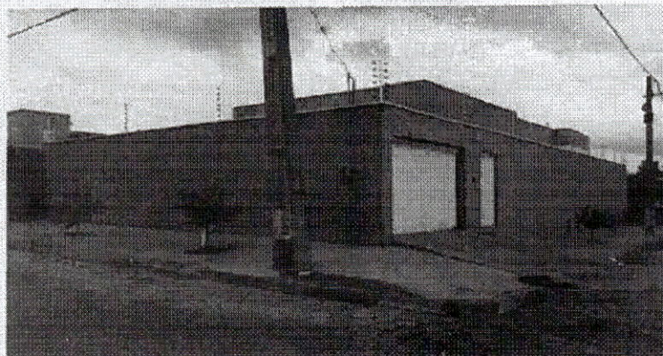
Imagem 02: Fachada Frontal e Lateral da obra
