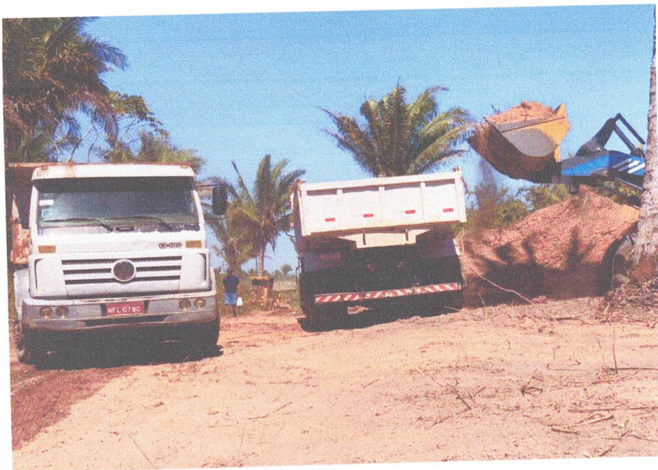
PIÇARRA DE JAZIDA PARA BASE DE PAVIMENTAÇÃO
