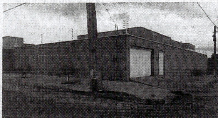
Imagem 02: Fachada Frontal e Lateral da obra
