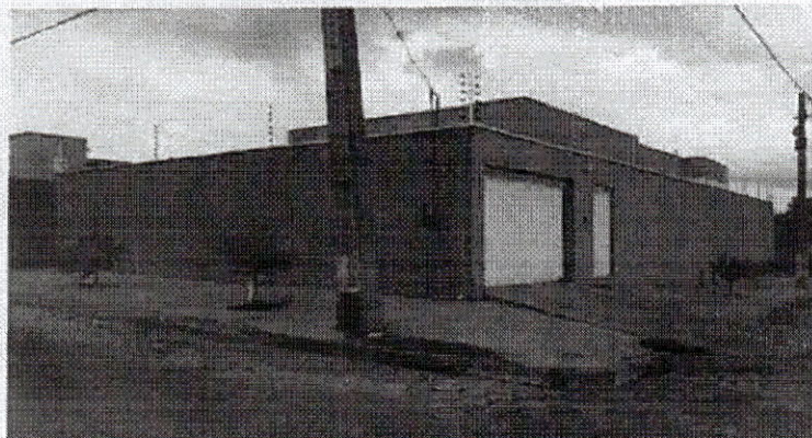
Imagem 02: Fachada Frontal e Lateral da obra
