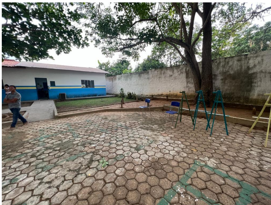
Área para construção de 2 salas de aula.
