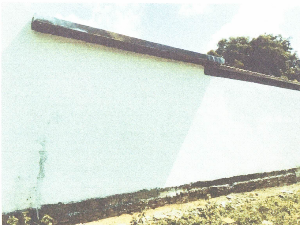
Reboco e pintura de muro externo. – EM EXECUÇÃO
