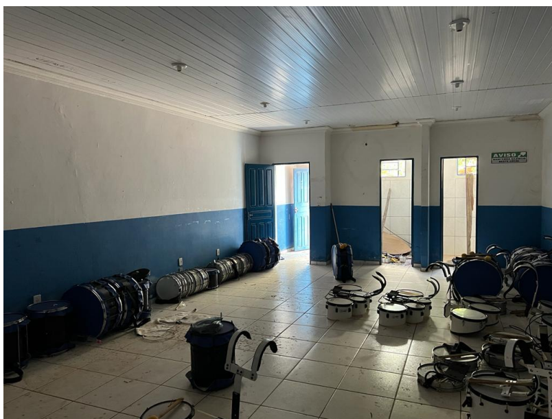
Área interna a ser demolida
