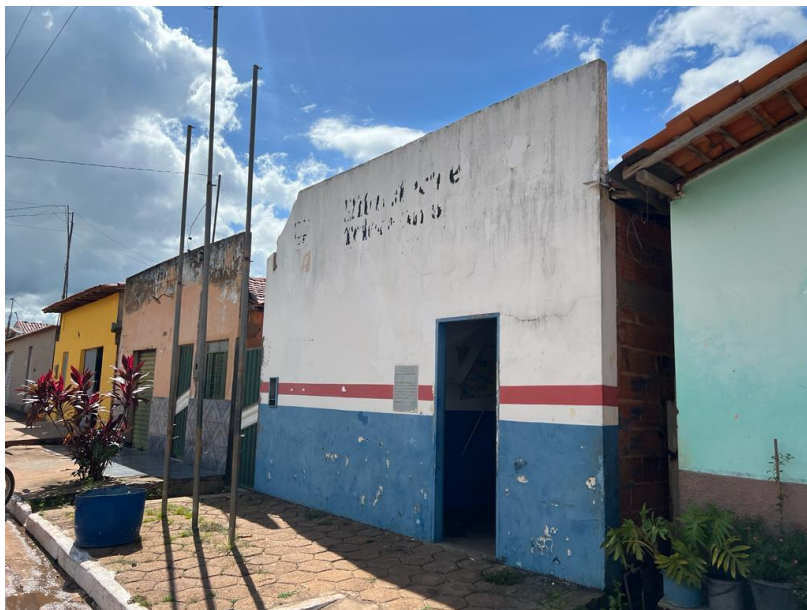
Fachada a ser demolida
