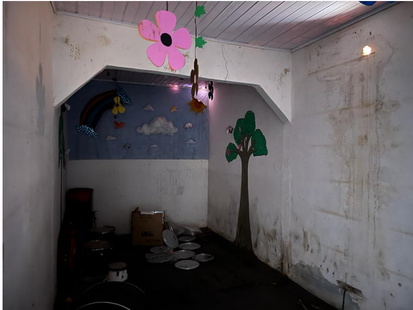
Área interna a ser demolida
