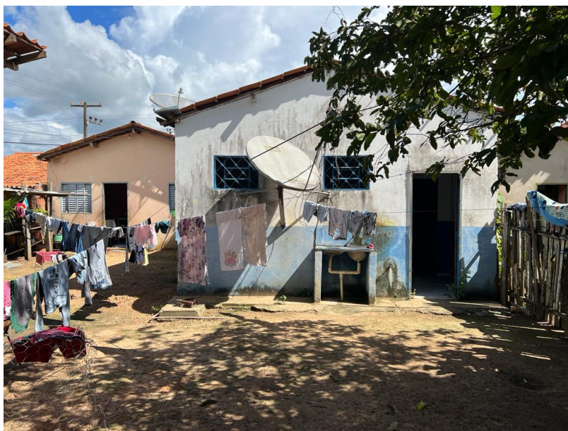
Área a ser demolida limite posterior terreno
