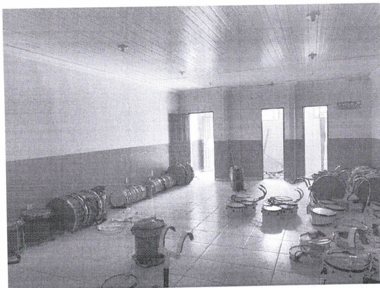
Área interna a ser demolida
