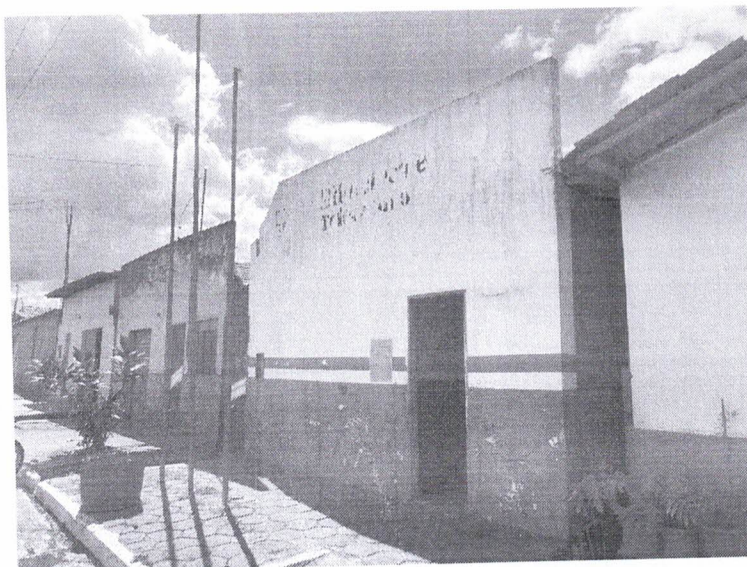
Fachada a ser demolida
