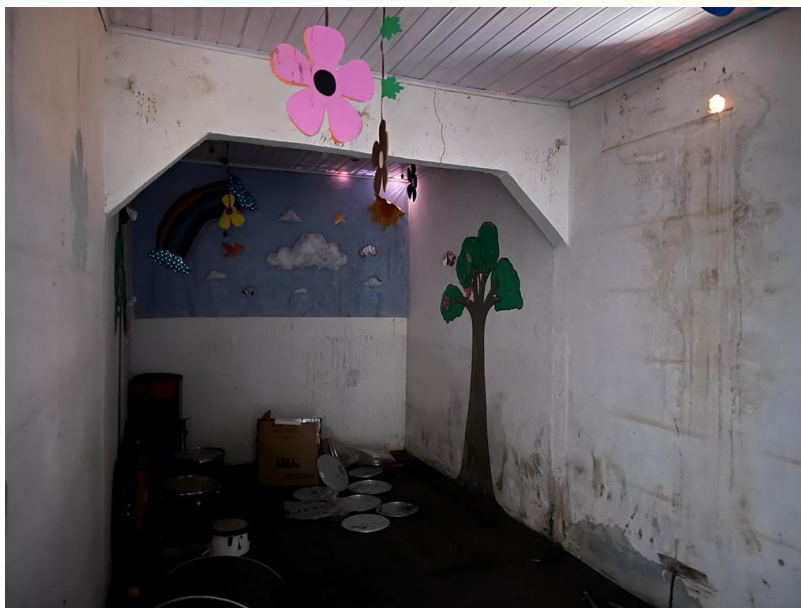
Área interna a ser demolida
