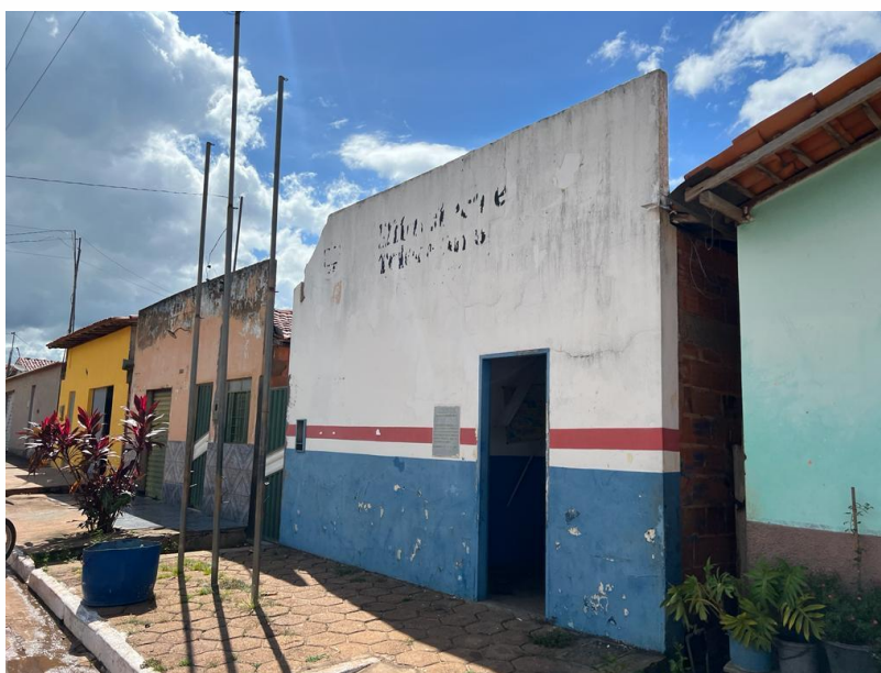
Fachada a ser demolida
