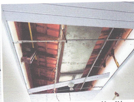
3. Forro danificado pelas chuvas. Estrutura reconstruída, inclusão de novas saídas d'água e calhas e recuperação elétrica.
