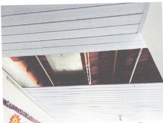
3. Forro danificado pelas chuvas. Estrutura reconstruída, inclusão de novas saídas d'água e calhas e recuperação elétrica.
