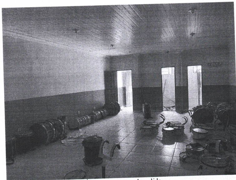
Área interna a ser demolida
