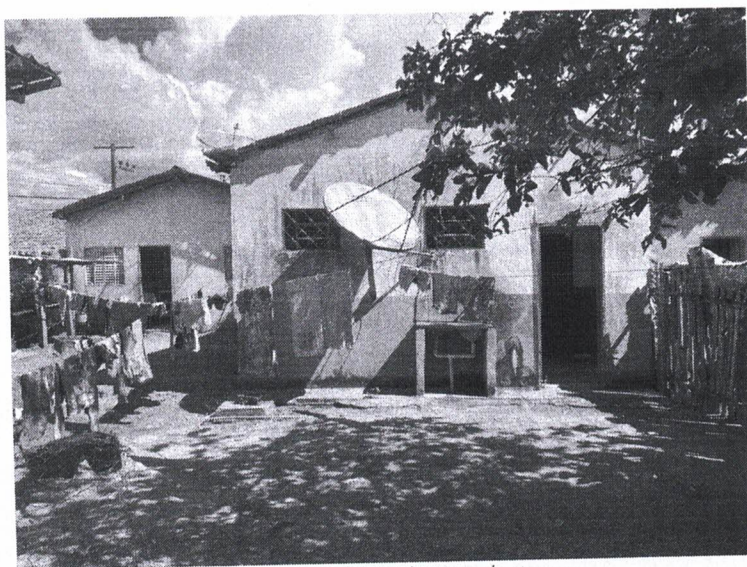
Área a ser demolida limite posterior terreno
