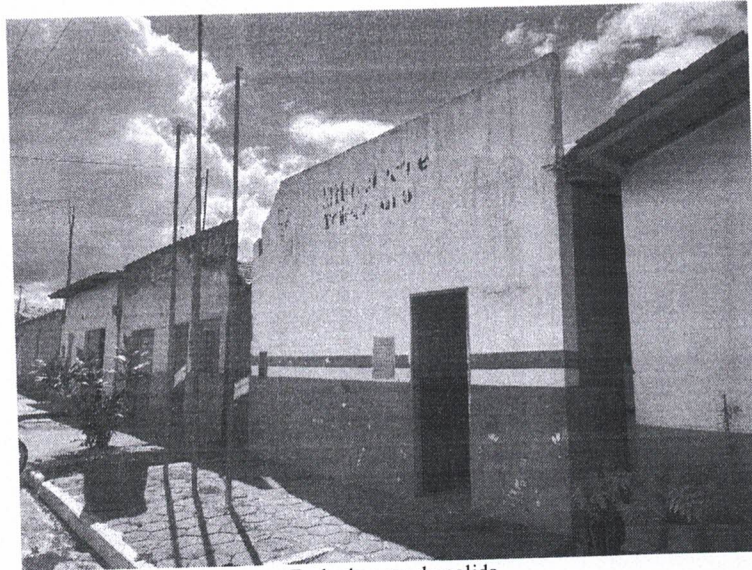
Fachada a ser demolida
