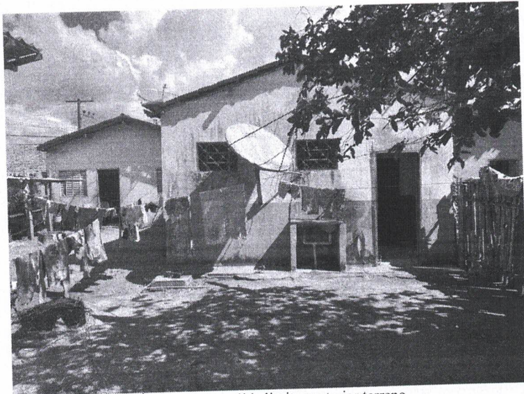
Área a ser demolida limite posterior terreno
