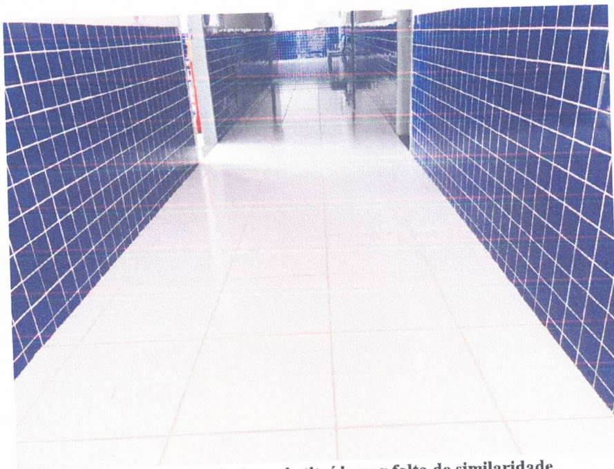
Revestimento cerâmico substituído por falta de similaridade.
