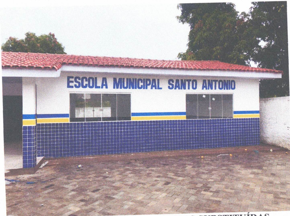
REVESTIMENTO 10X10 E JANELAS SUBSTITUÍDAS
