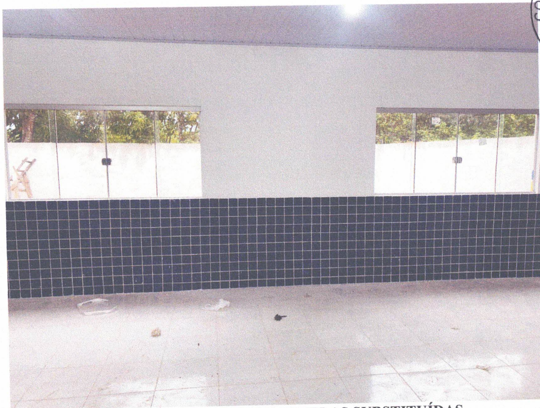
REVESTIMENTO 10X10 E JANELAS SUBSTITUÍDAS
