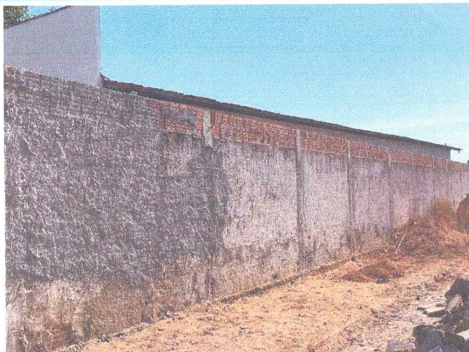
Foto 3 - Serviço de Alvenaria, Chapisco do Muro e Caiação (à executar)
