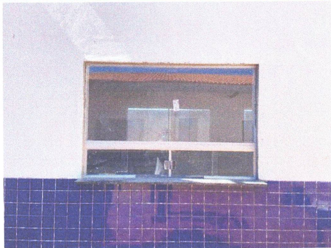
Foto 6- Execução de Janela tipo Blindex
