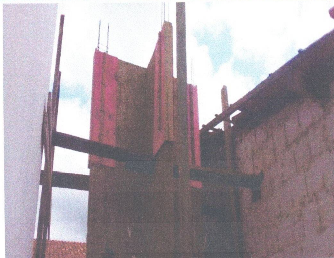
Foto 9 - Execução de Vigas e Laje (à executar), Reboco e Instalação da Caixa D'água (à executar)
