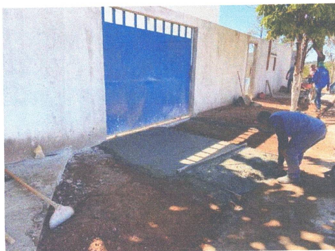
Foto 8 - Execução de Passeio (Calçada)
