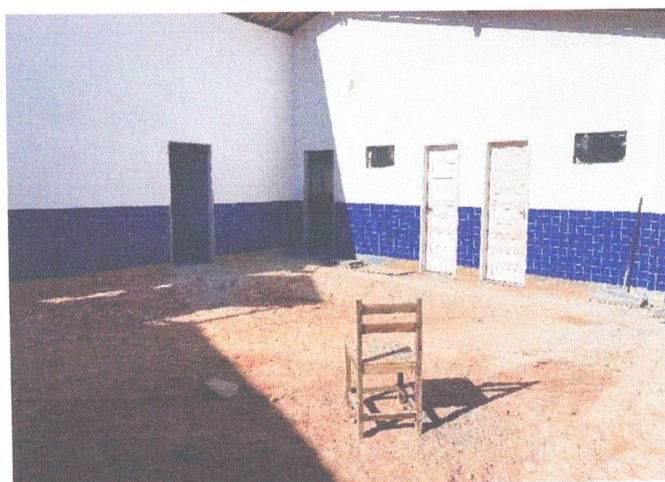
Foto 4 - Execução de Revestimento Cerâmico 10x10, Emassamento e Pintura em Látex (à executar)
