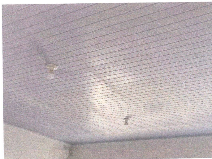
Foto 2 - Serviço de Forro e Roda Forro
