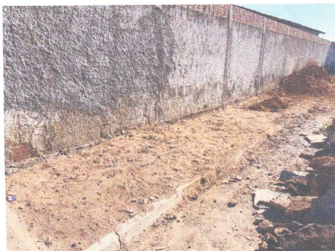
Foto 7- Execução de Passeio (Calçada)(à executar)
