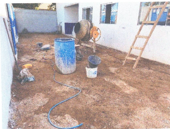
Foto 10- Execução de Demolição, Piso Cimentado e Pintura de Piso Acrílico (à executar)
