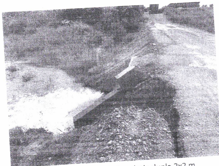
Ponto de construção de galeria dupla 2x2 m Localização: -5.171048985592351, -47.34524151154306
