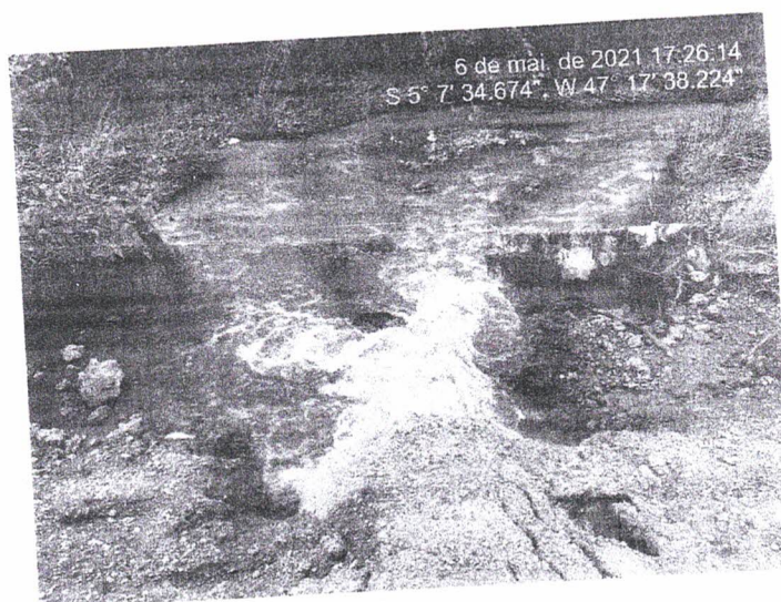
Ponto de Construção de galeria dupla 2x2 m Localização: -5.126224, -47.294007
