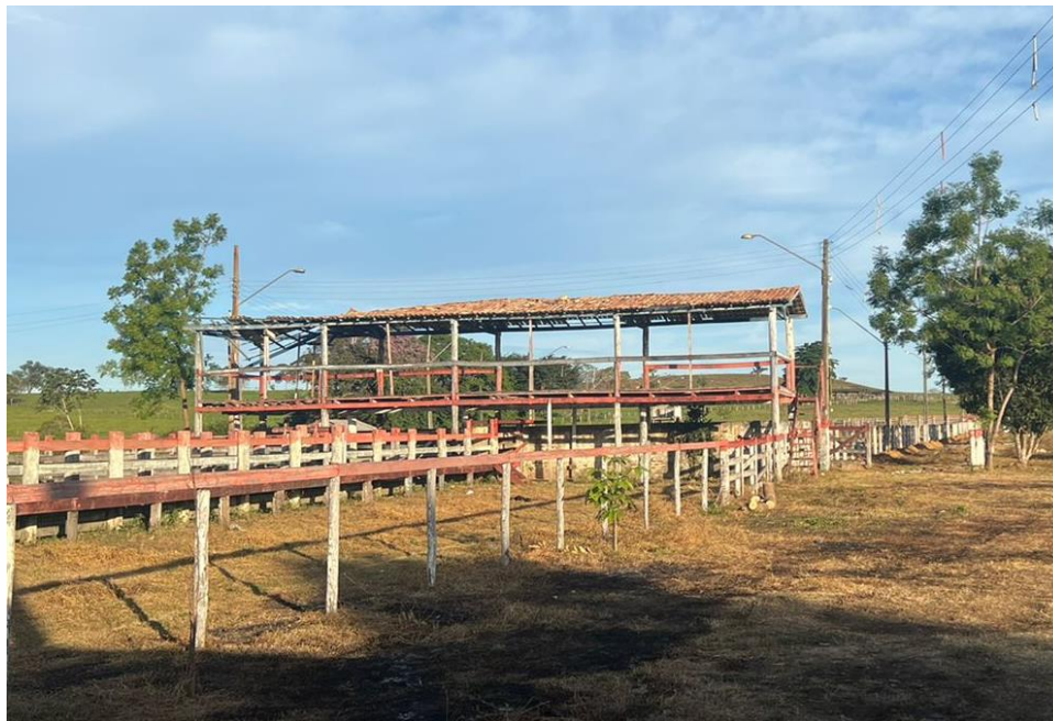
ESTRUTURA DE PALCO A SER SUBSTITUÍDO POR CONCRETO
