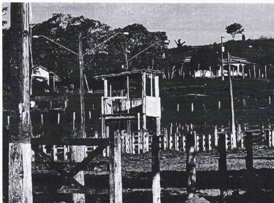
ESTRUTURA DE PALCO A SER SUBSTITUÍDO POR CONCRETO
