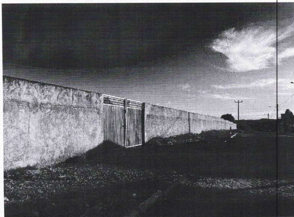
CALÇADA A SER PAVIMENTADA EM BLOQUETE.
