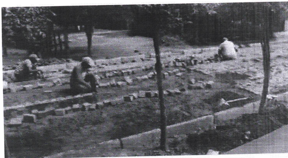
Obra sendo executada
