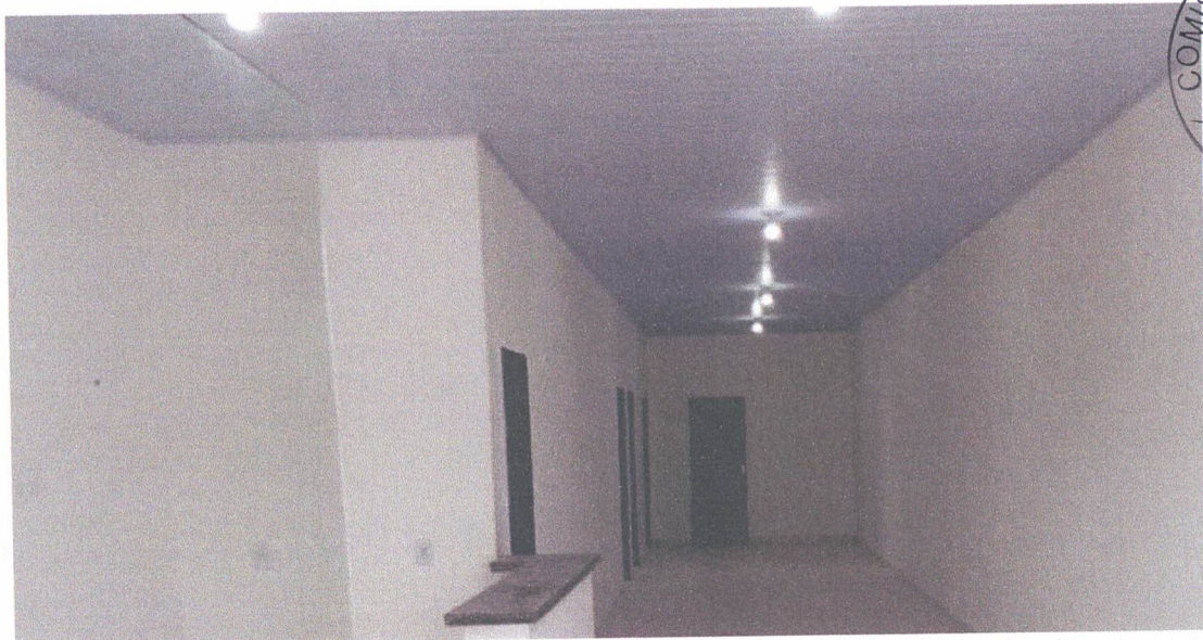
Substituição de forro de gesso para PVC (em virtude de a manutenção ser menor).
