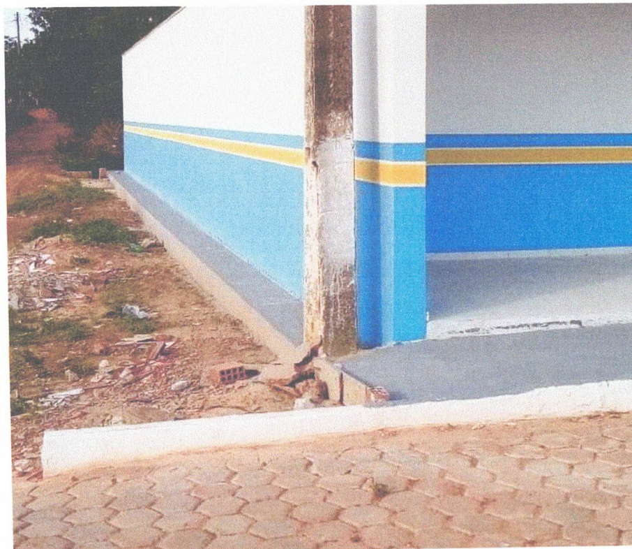
Execução de calçada de proteção (a fim de proteger o prédio de infiltrações de chuvas que assolam essa parede externa).
