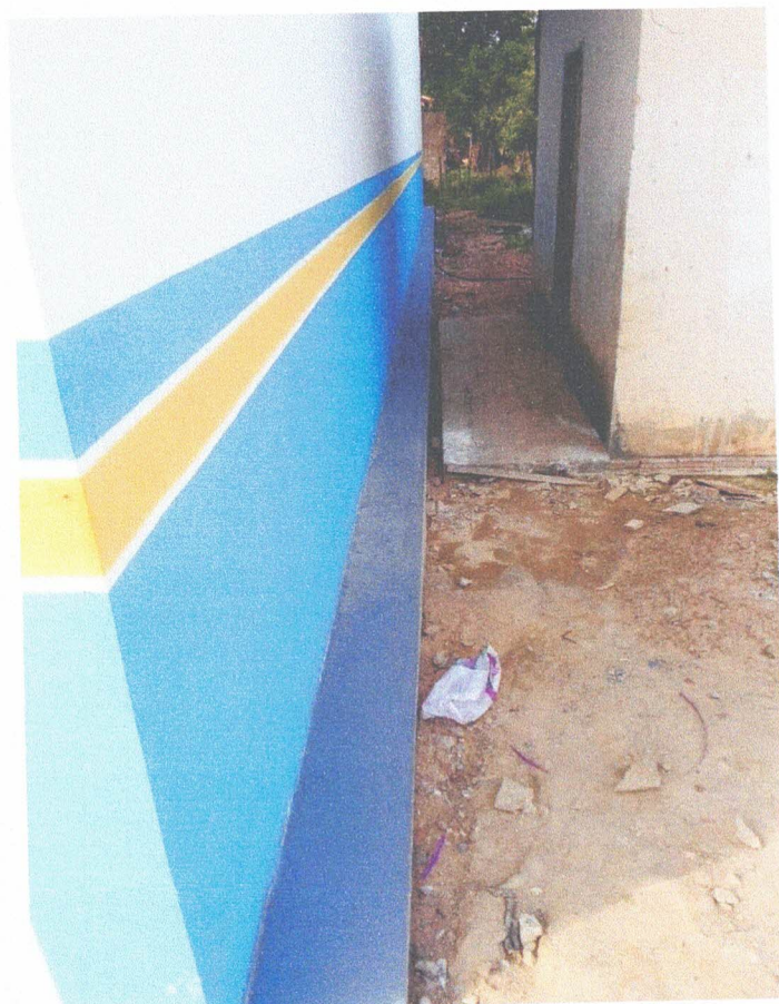
Reboco de muro externo (a fim de proteger o prédio de infiltrações de chuvas que assolam essa parede externa)
