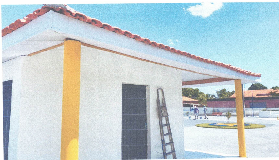
Forro em quiosques.
