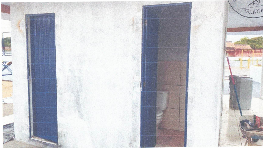
Área dos banheiros (em construção).
