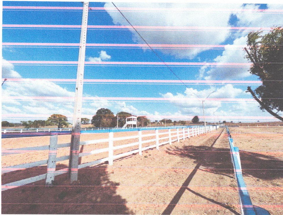
Pilares e cercas executadas.
